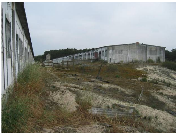
Fotografia 7 - Vista para a unidade C, de sul para norte, entre os edifícios de produção 5 e 6.
