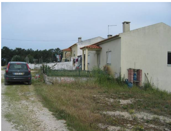
Fotografia 13 - Vista para as habitações junto à unidade C.
