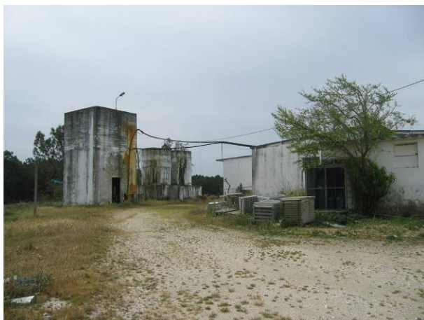
Fotografia 10 - Captação de água e depósito.
