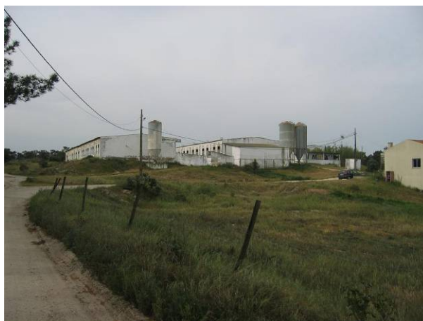
Fotografia 6 - Vista para a unidade C, edifícios 5 e 6 e silos.
