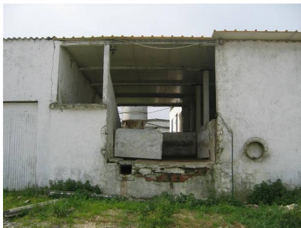
Fotografia 2 - Vista para cais de embarque na unidade B, no topo do edifício de produção 4.
