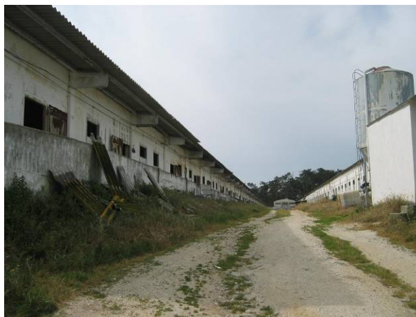
Fotografia 8 - Vista para a unidade C, entre os edifícios de produção 6 e 8.
