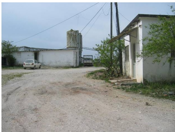
Fotografia 3 - Vista para o escritório, arrumos e silos na parte norte da exploração.
